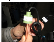
Abbildung 27: Hochdruckfühler.
