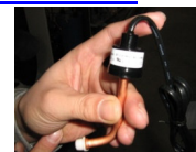
Abbildung 28: Niederdruckfühler.
