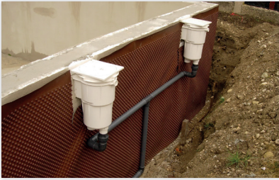
Verrohrungsbeispiel Einbauskimmer
